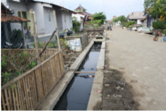
Pembangunan dan peningkatan jaringan drainase permukiman
