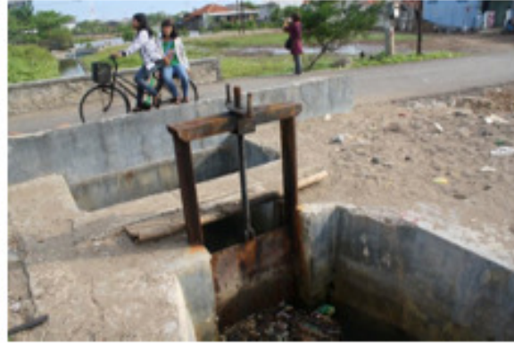
Penyediaan pintu air untuk mengendalikan keluar masuknya air lat dan air limpasan pada saat hujan
