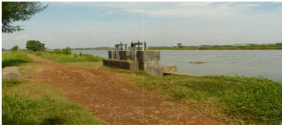
Pembangunan kanal (sudetan) untuk memperbesar kapasitas drainase makro bagi Kota Pekalongan
